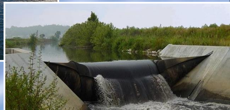
Açude insuflável/ AH Vale do Lis
